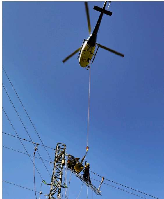
Déploiement de la fibre sur les lignes haute tension d'EDF
